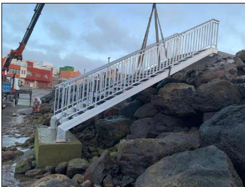
Figura 15. Ejemplo de escalera en el dique de Pozo Izquierdo.
