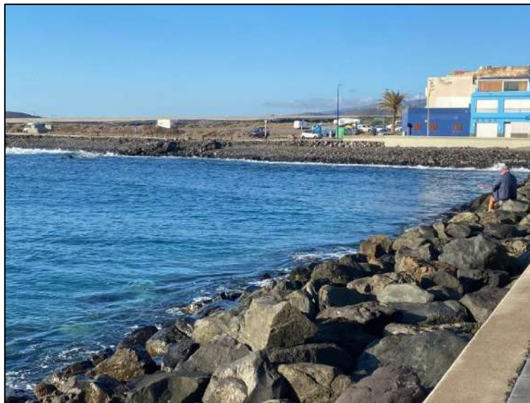
Figura 2. Situación actual vista desde el dique.
