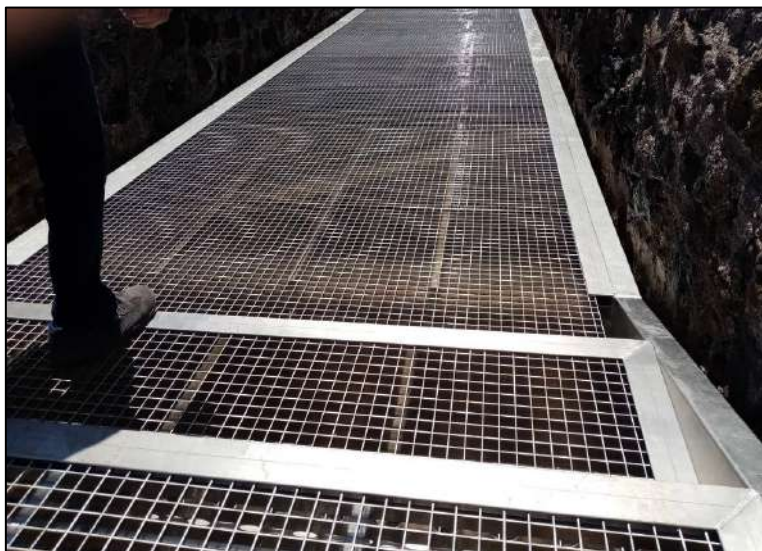
Figura 17. Ejemplo de estructura del Muelle Viejo. Playa de Arinaga.
