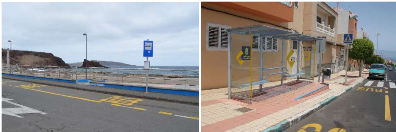
Imagen: Parada de guaguas Tr.G.58 con señal vertical y horizontal sobre calzada. Marquesina y parada de guagua en el Municipio.
