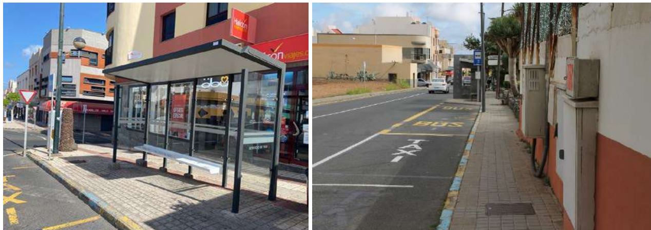
Imágenes: Paradas Tr.T.07 en la Avd. Carlos V y una parada de taxi con señalización horizontal en la calzada en la Avd. de América.
