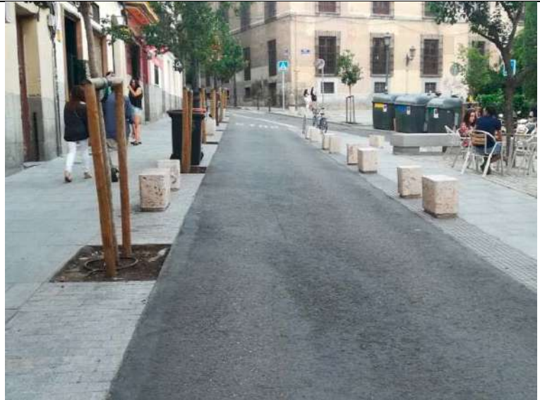
Imagen: Ejemplo de zona de plataforma única sin espacio de tránsito compartido entre peatones y vehículos con delimitación del espacio de uso peatonal mediante elementos y pavimento táctil.
